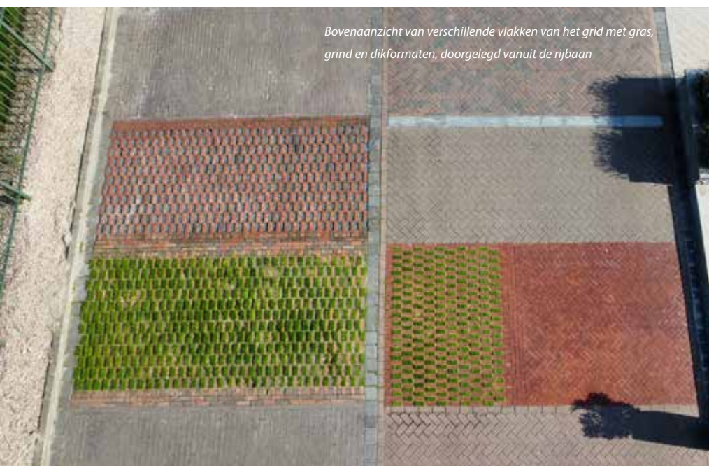
Aanleggen van het Water Passing Stone Grid
