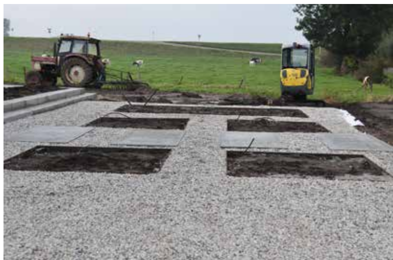
De aansluitingen voor druppelslangen liggen al klaar in de perken in een fraaie grindverharding.
