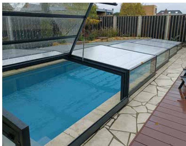
De flagstones zijn deels kapotgeslagen en afgebraamd om de vormen passend te maken; dat was nog een flinke klus
