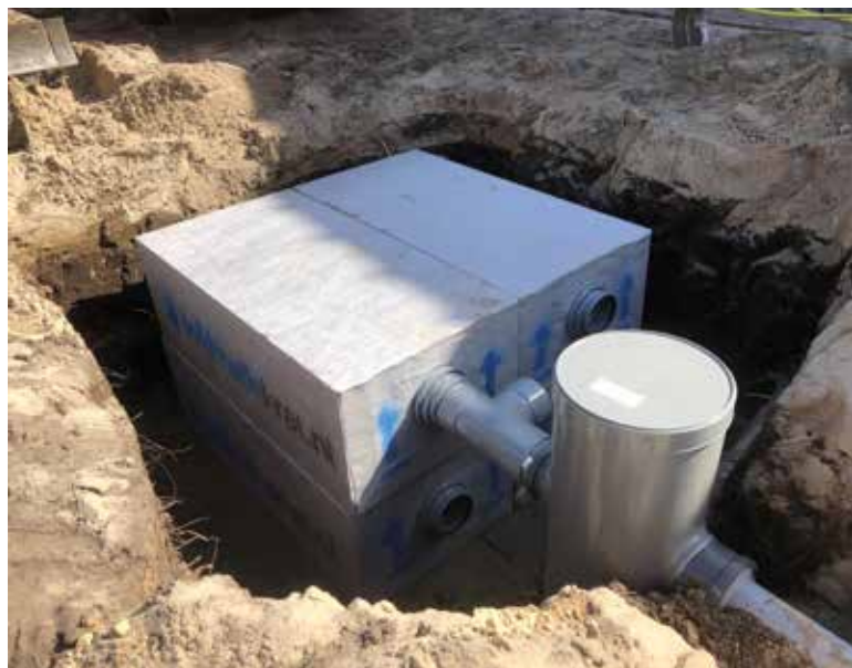
Hier is gekozen voor een extra verbinding naar een tweede krat, om het water sneller te kunnen afvoeren.
