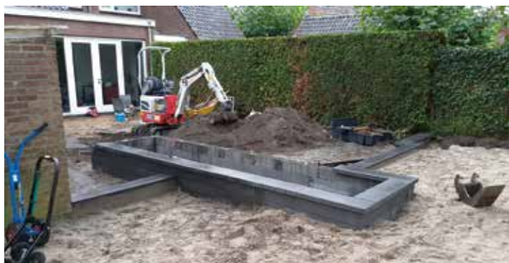
Aanleggen bestratingsbed: afhankelijk van ondergrond en toegepaste keramische tegels
