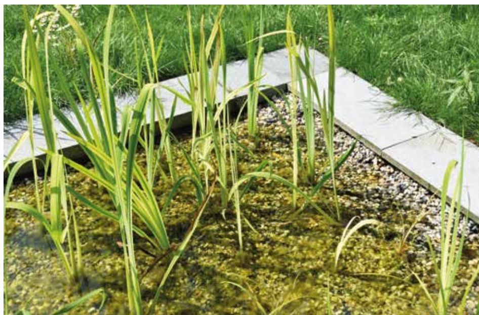
Het lava-grindpakket van het plantengedeelte in een verhouding 30/70 procent.
