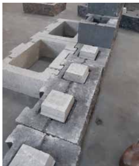
Een droog gestapelde muur wordt opgebouwd zoals Lego.
